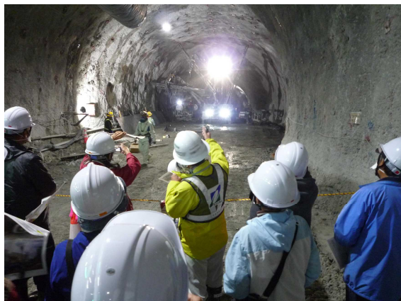
「学遊塾」第5回 利賀ダム現場見学
